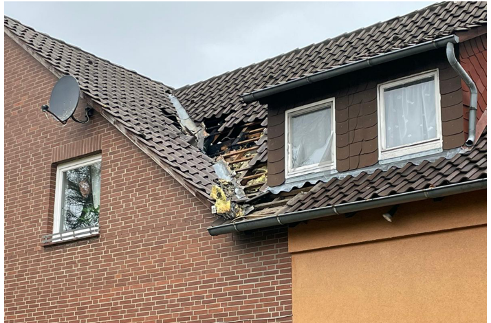
Auf etwa 5 Quadratmetern öffneten die Feuerwehkräfte das Dach, um das darunter liegende Feuer zu bekämpfen.
