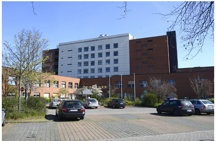
Das Lehrter Krankenhaus zoll geschlossen und ein Medizinisches Versorgungszentrum (MVZ) errichtet werden.
