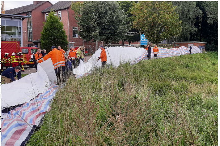
Die Feuerwehrkräfte stellen das Hochwasserschutzsystem
